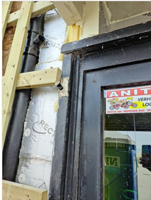
verwijderen montage beugel
