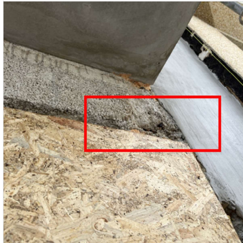
uitvoeren betonherstel balk
