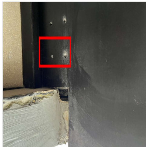
aansluitpunt wachtbuis fiber
