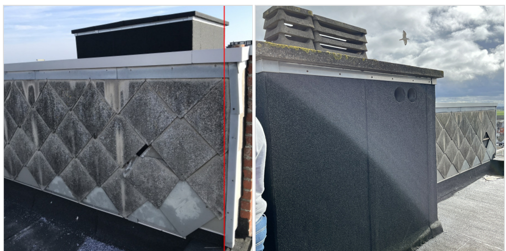
randaansluitingen onafhankelijk maken van achtergevel schouw buurgebouw
