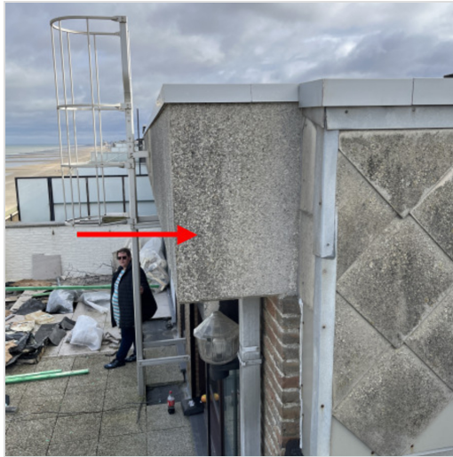
randaansluiting voorgevel en blinde zijgevel
