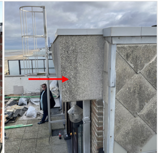
randaansluiting voorgevel en blinde zijgevel
