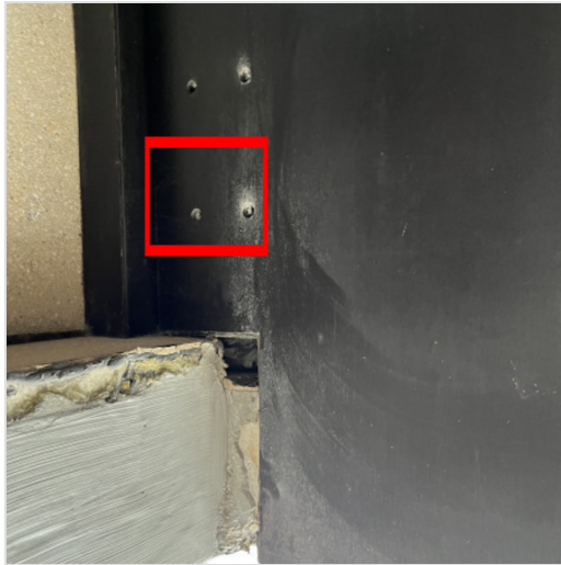
aansluitpunt wachtbuis fiber
